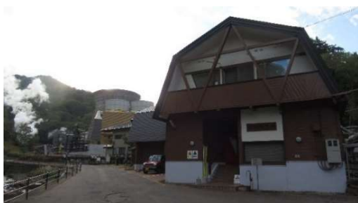
松川地熱館と冷却塔（建物左奥）
