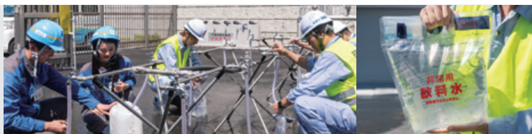
▲持参されたポリタンクや給水袋に飲料水を入れられる給水拠点を設営
