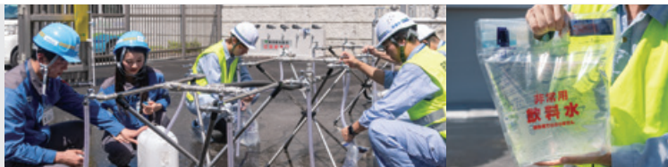
▲持参されたポリタンクや給水袋に飲料水を入れられる給水拠点を設営
