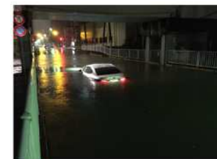
八高線アンダーパス（八王子市）
