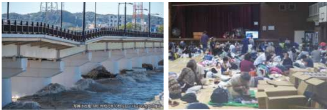
図 17 台風第19号 9 の被害と避難所の様子
