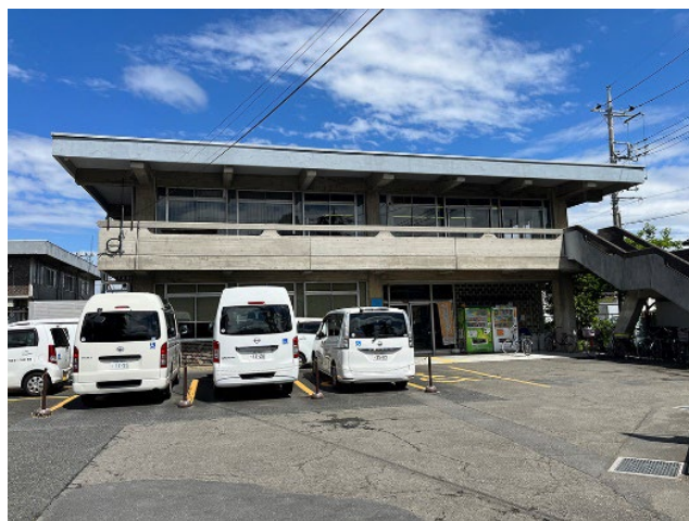
中央福祉センターの外観
