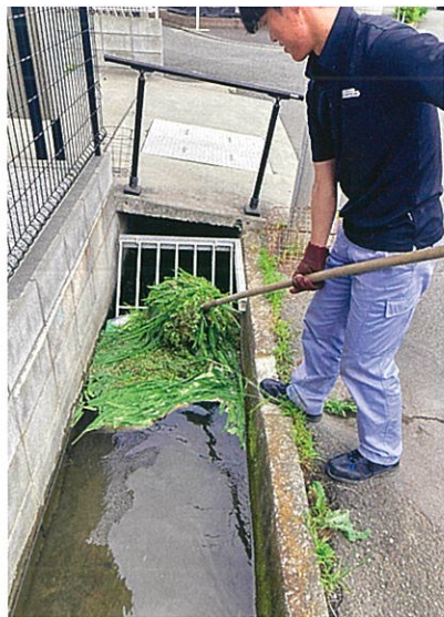
水草が詰まって水位が上がっている
