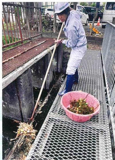
石川堰での水草除去作業
