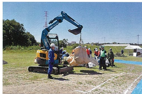
大型積み土嚢工法作成の様子
