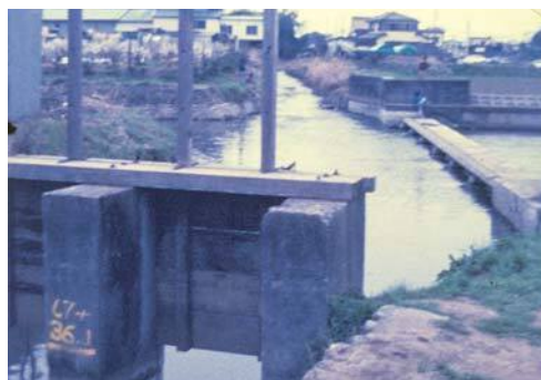
奥からの流れが日野用水。水量を調整していた水門は現存しています
