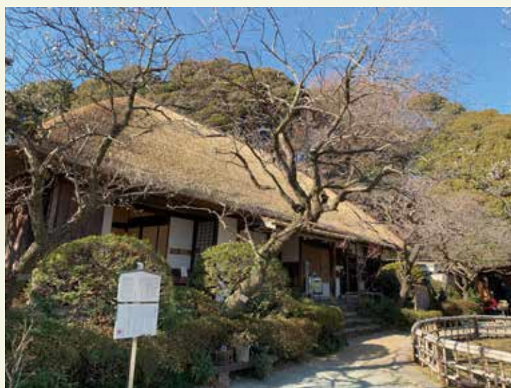
葺き替え後の松連庵 (2024 撮影)
