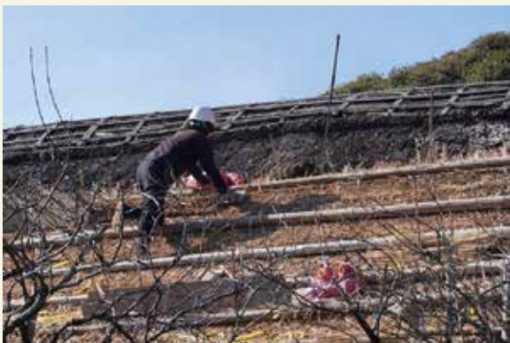
積み上げた茅の先端部をガンギを使って叩いて整えます。同じ作業を13段繰り返します。
