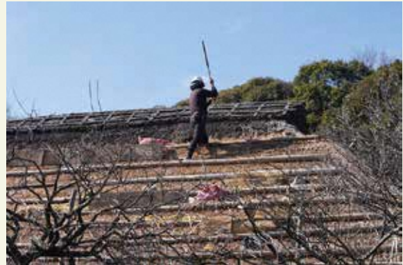
長くて重い針と呼ばれる道具に縄をつなぎ、屋根裏まで刺し通して茅を梁(はり)に固定します。
