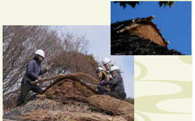
棟に竹箆巻(たけすまき)を施している様子。
