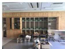
教室後方は全面が収納となっている。児童・生徒のケガを防止するため取っ手などの凸部はない。
