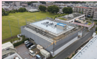
▲8月の様子(屋上防水工事中)
