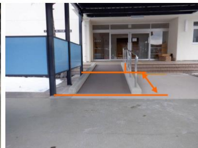
改修後の個体が緩やかなスロープ (登り口の位置が手前の柱)
