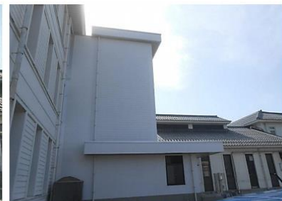
エレベーター棟設置後の外観
