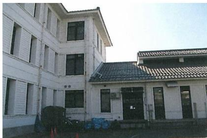
エレベーター棟設置前の外観
