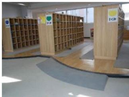
東校舎の昇降口に設置されたスロープ
