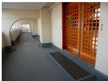
スロープの設置された屋内運動場の出入り口
