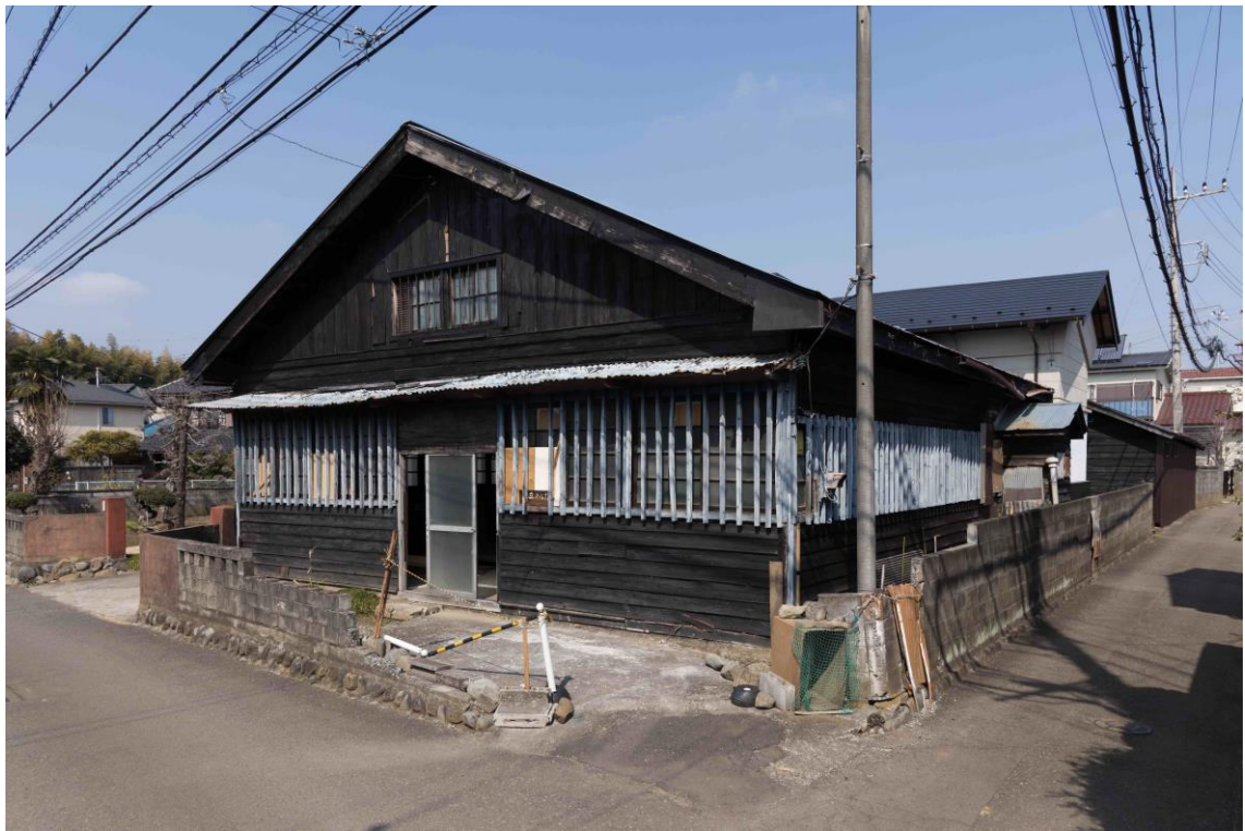
南東側の外観：旧撚糸工場の全景。東側の奥に蔵と旧宿舎が見える。
