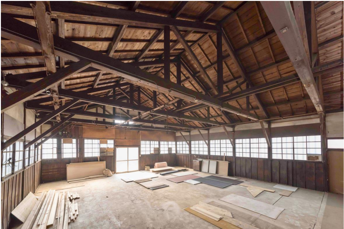
旧撚糸工場の内観：柱の上にトラスが載る架構
