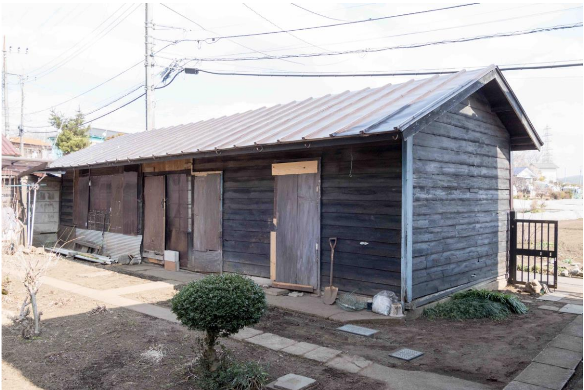
南西の外観：旧宿舎の全景。南側に出入口が4カ所あった。
