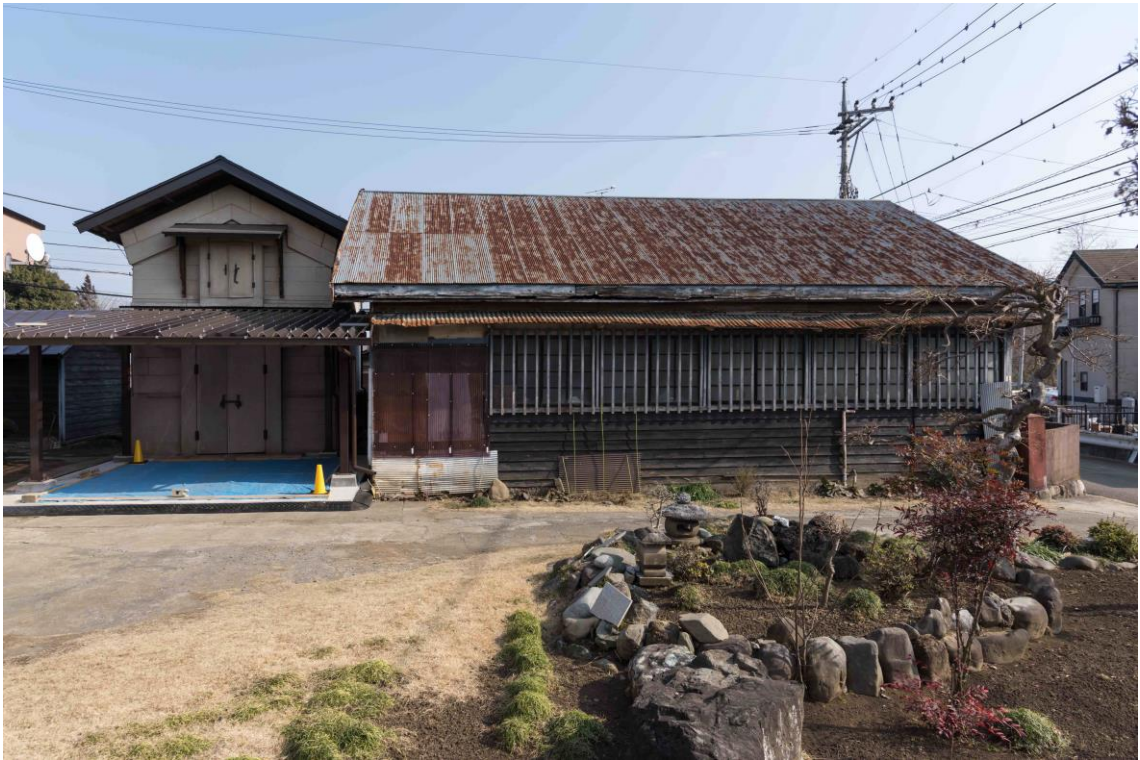
西側の外観：旧撚糸工場と蔵の全景。
