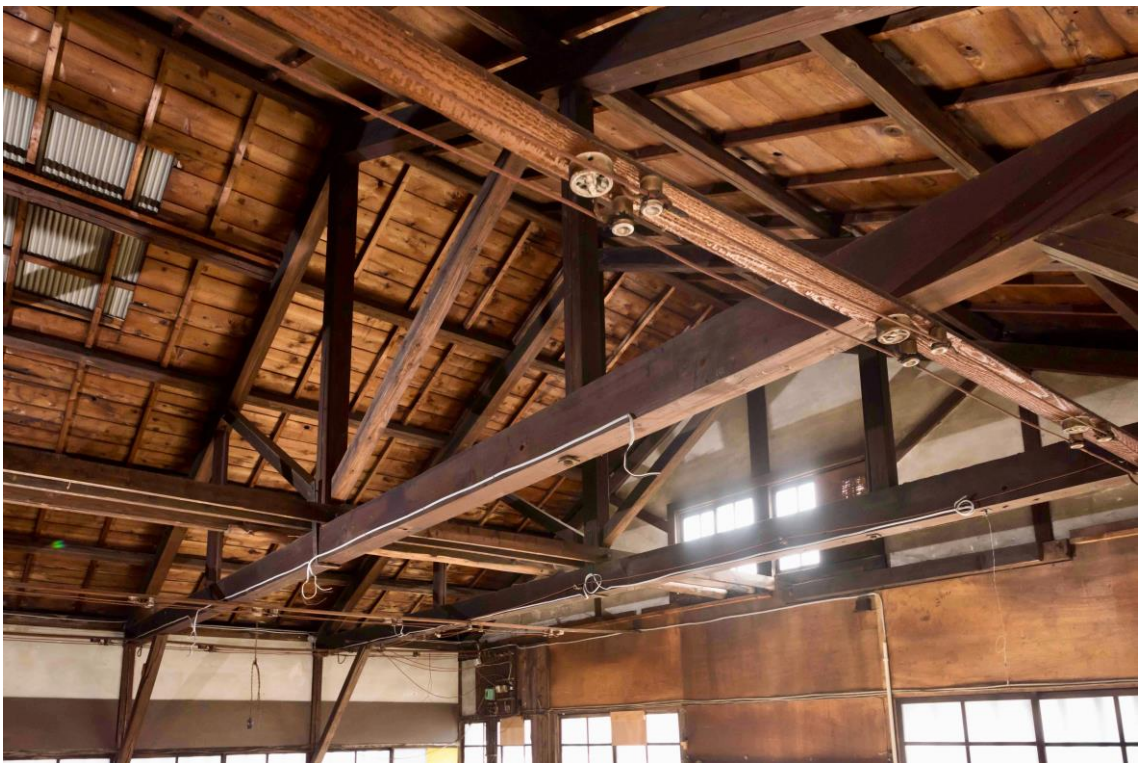
木造トラス詳細：真束があり箱物金物で吊られている。(キングポストトラス)
