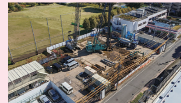
▲くい工事、材料搬入の様子(令和4年11月撮影)
