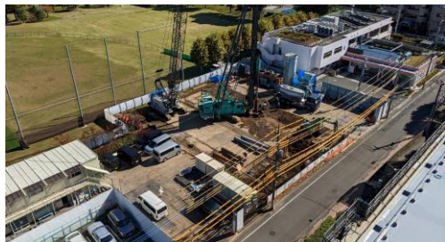
令和4年11月撮影 杭工事、材料搬入の様子
