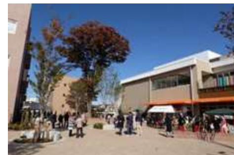
多摩平の森 A街区 医療・介護施設等集積拠点 “て・とてラス”
