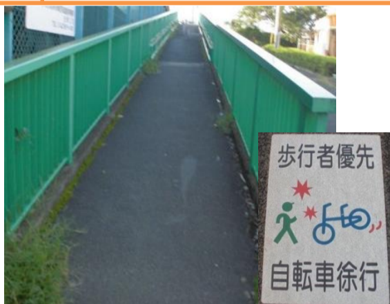
7 平山四丁目26番地先 平山陸橋脇スロープと陸橋下地下道出口の歩道
