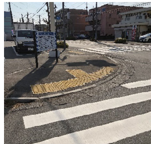
幹線市道Ⅰ-9号線では、歩道の擦り付け勾配の緩和(左)、国道20号との視覚障害者誘導用ブロックの接続(右)
