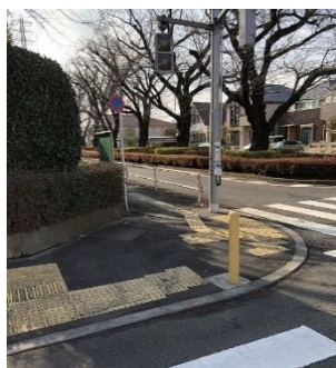
歩車道が区別され、視覚障害者も渡りやすい交差点に改良されました
