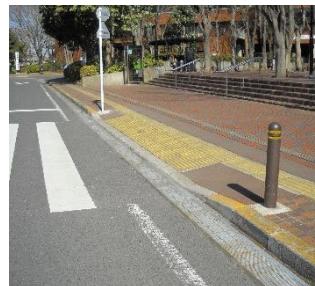
市役所と日野中央公園を結ぶ横断歩道は、擦り付け部の勾配が急になっている
