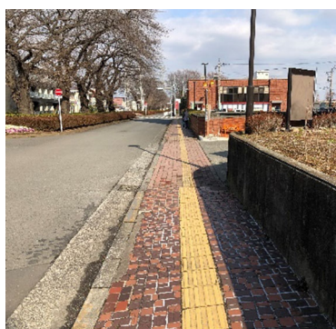
市役所北側(歩道有効幅員 1.67m)
