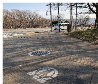
日野バイパスの視覚障害者誘導用ブロックとの接続が望まれる
