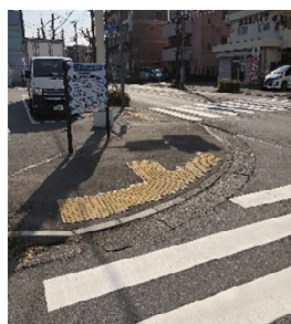
歩道の擦り付け勾配が急になっている
