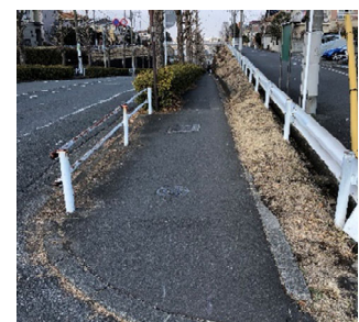
中央自動車道の下、日野駅と結ぶ区間は縦断勾配が 7~8%
