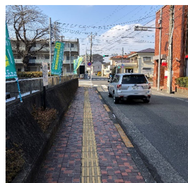
市役所東側(歩道有効幅員 1.7m)
