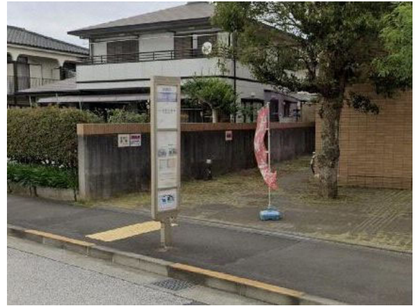
歴史館前のバス停留所では、乗り場を案内する視覚障害者誘導用ブロックが整備されています
