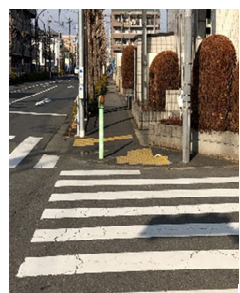
歩道の擦り付け勾配が急になっている
