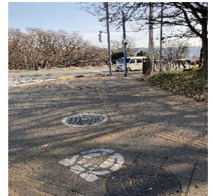
幹線市道Ⅰ-9号線では、歩道の擦り付け勾配の緩和(左)、国道20号との視覚障害者誘導用ブロックの接続(右)
