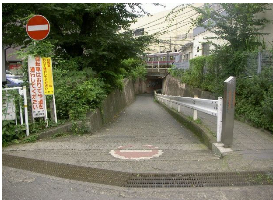
整備前の地下道
