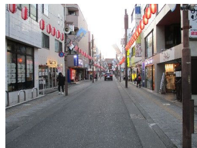
一方通行化により歩道を整備し、無電中化された高幡不動駅と高幡不動尊を結ぶ幹線市道Ⅱ-9号線
