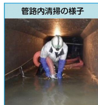
図 6-13 管路内清掃の様子
