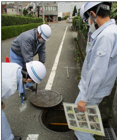
図 3-20 下水道 BCP に基づく訓練の様子（左）、マンホール型トイレ施設（右）
