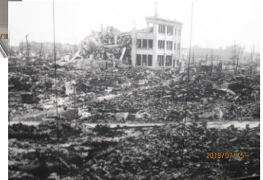
広島市内の9割が破壊された
