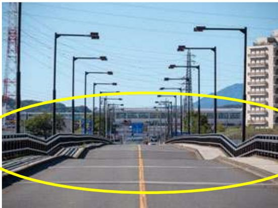
台風後の橋桁が落ちて波打つ日野橋
