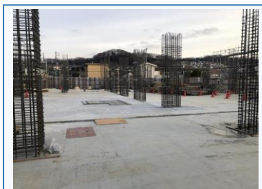
▲エントランスから 多目的ルームにかけて
