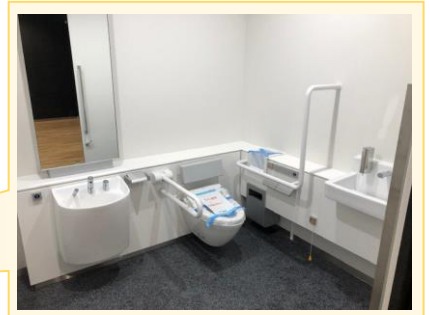
▲多目的トイレ 1F：オストメイト・ベビーチェア・ シャワー・多機能シートを完備 2F：オストメイトを設置
