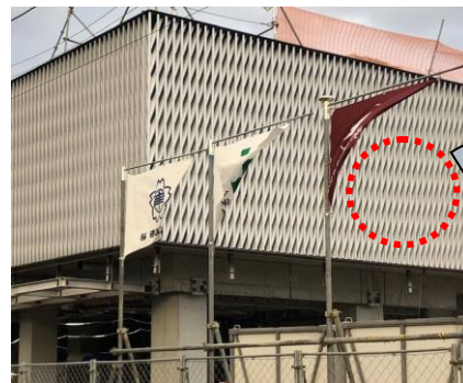
▲施工中建物外観
