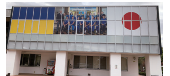
▲西側窓のラッピング
