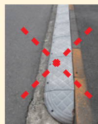
乗り上げブロック
