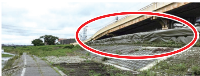
◀ 滝合橋下右岸の様子
