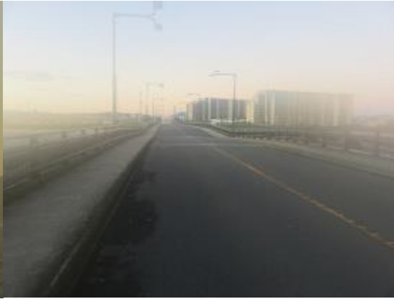
図 25 日野橋の状況
