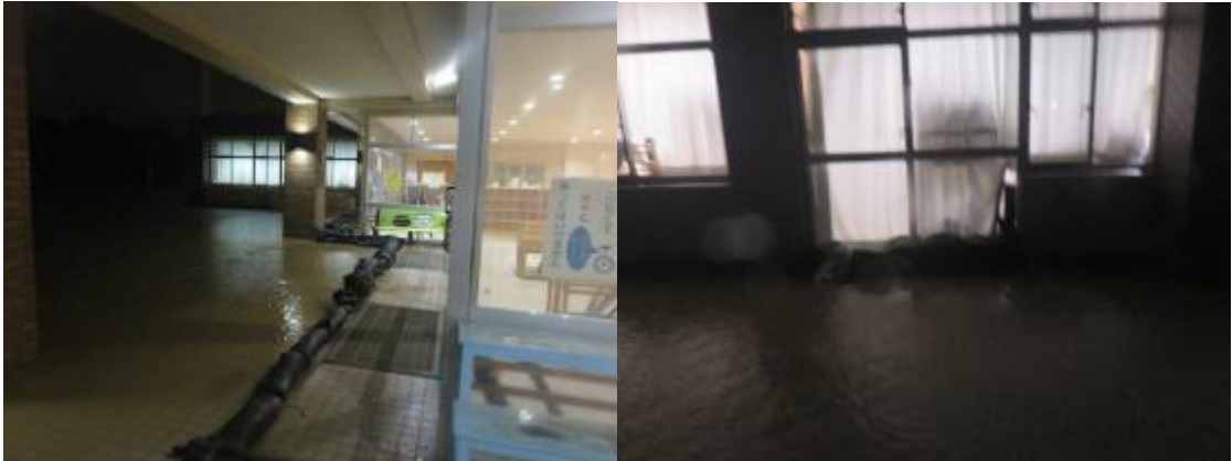
図 27 平山小学校浸水対策
