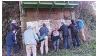
▲日野煉瓦でできたJR中央線多摩川橋梁の橋台
