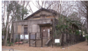
▲修復前の日野桑園第一蚕室
