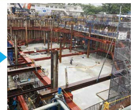
コンクリート打設後
