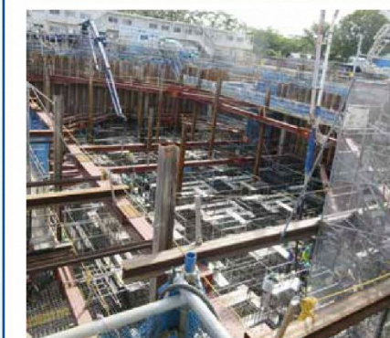
コンクリート打設前
