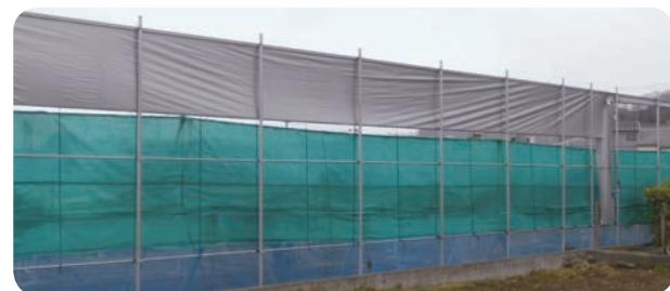
▲農薬の飛散を防止する「防薬シャッター」。市では、このシャッターの設置に対して補助金などの支援をしています。
