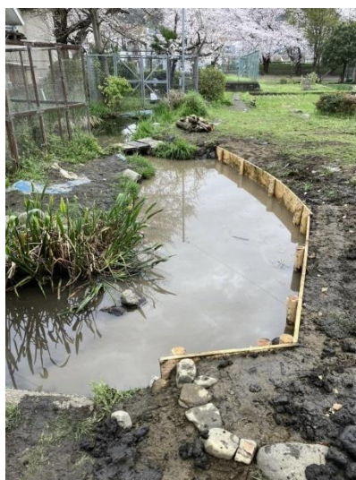
図 35 滝合小学校のビオトープ(浚渫作業後)
