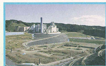
▲二ツ塚処分場（後方に谷戸沢処分場があります）
