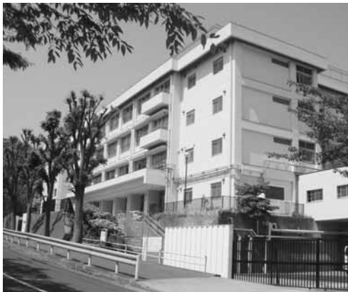
耐震補強工事等が完了した校舎
