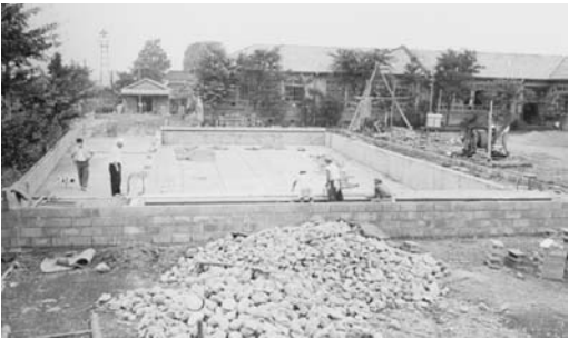
日野第二小学校プール建設工事(昭和31年)
