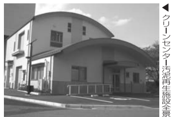
右施設内生物・薬液洗浄塔 クリーンセンター汚泥再生施設
