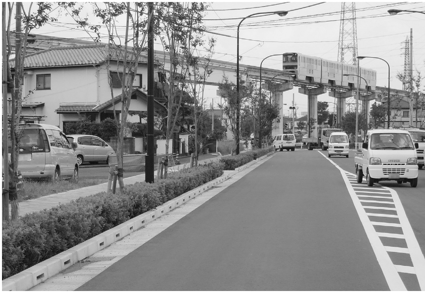
▲土地区画整理地内の道路が完成したスポーツ公園交差点前の通り
