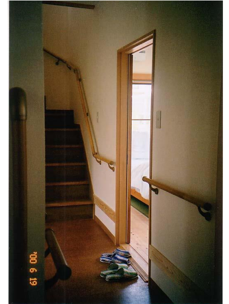
玄関ホール。手摺を設置
