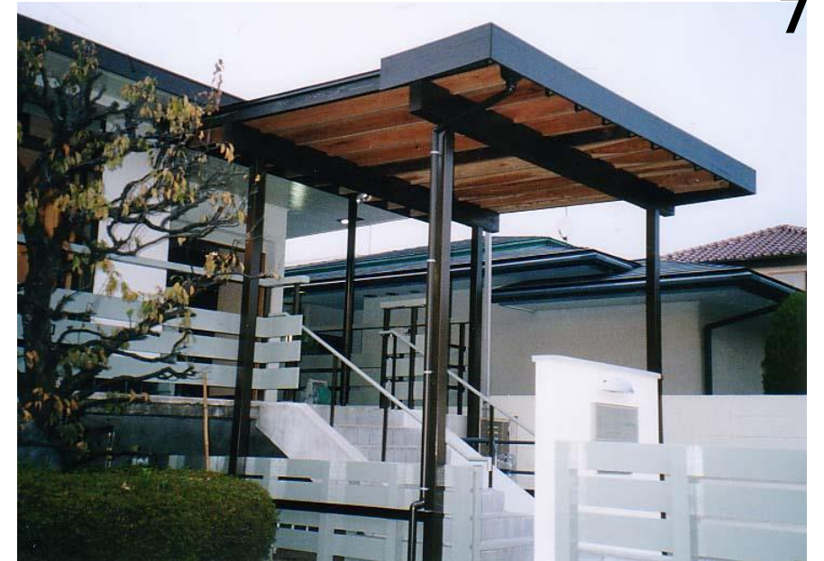
段差解消機の 上部に設置された庇
