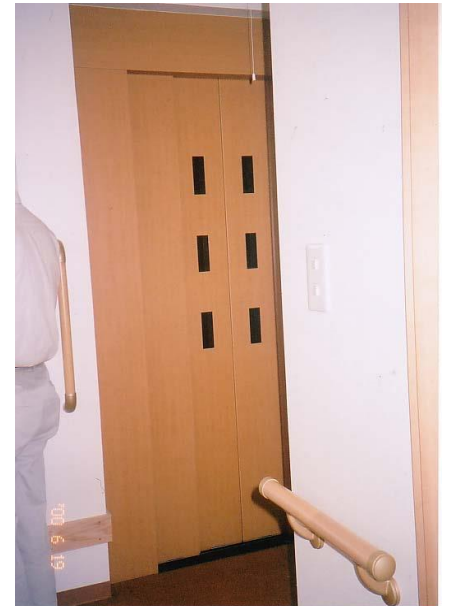
エレベーターを設置
