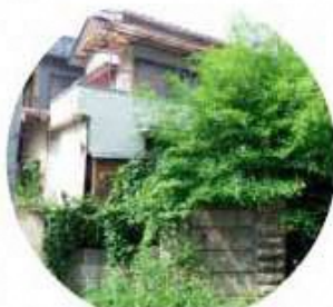
放置された空き家
