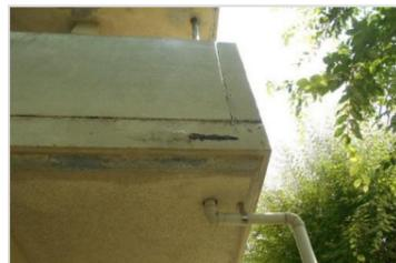
外壁の鉄筋露出（川原付団地）
