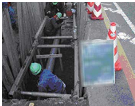
【汚水管きょ工事】
