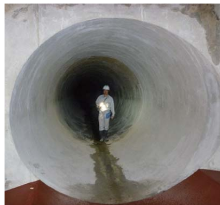
【豊田幹線（管路内部）】
