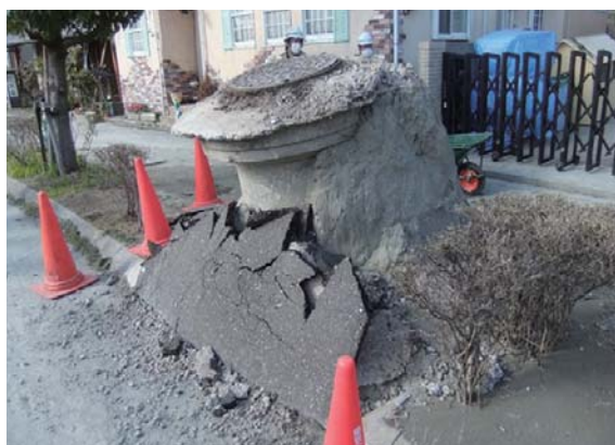
【東日本大震災 浦安市の被害状況】
