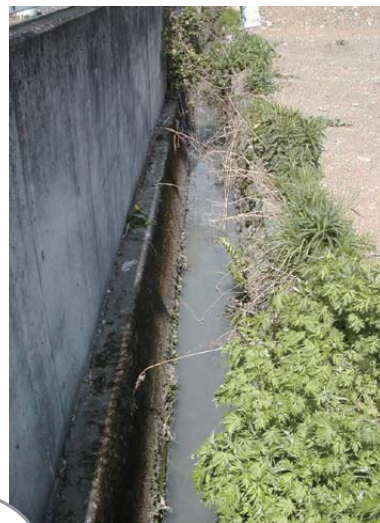
【下水道管きょ(汚水)へ未接続の地区の側溝】
