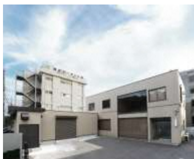
本社工場・別棟
