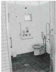
だれでもトイレ室内
