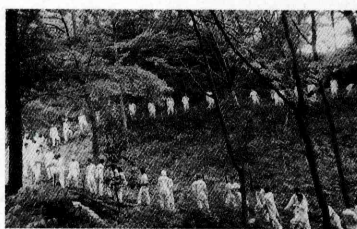
バケツリレーで碎石を運び階段補修しました
