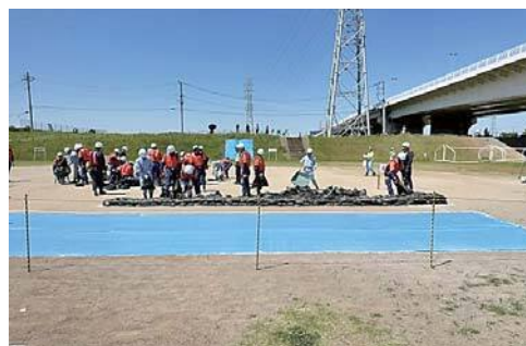
積み土嚢工法作成の様子
