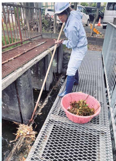
石川堰での水草除去作業
