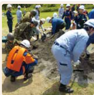
水防工法(土嚢作成)の様子
