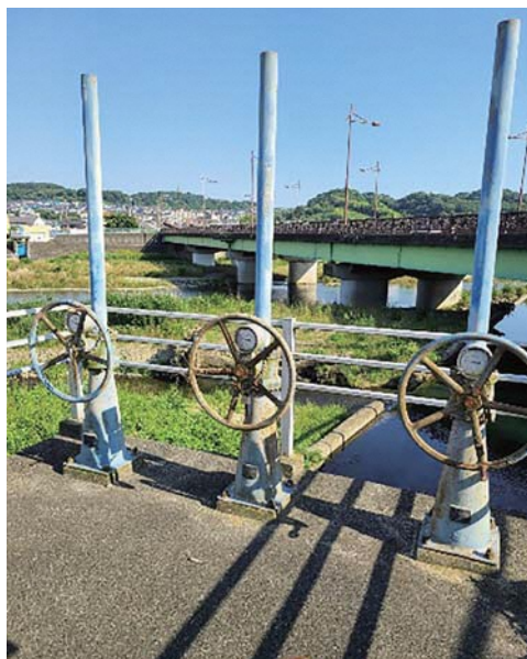
豊田・堀之内用水樋管
