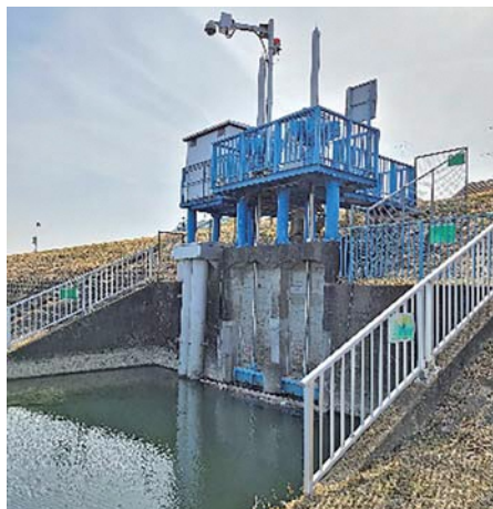
日野用水樋管
