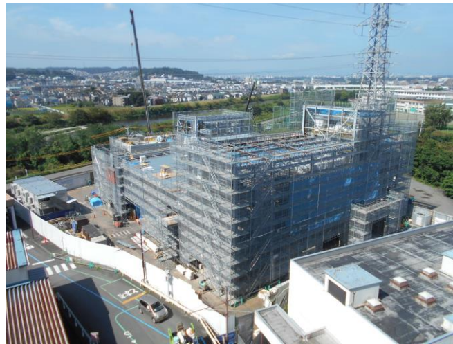
現焼却施設からの全体写真（9月5日撮影）
